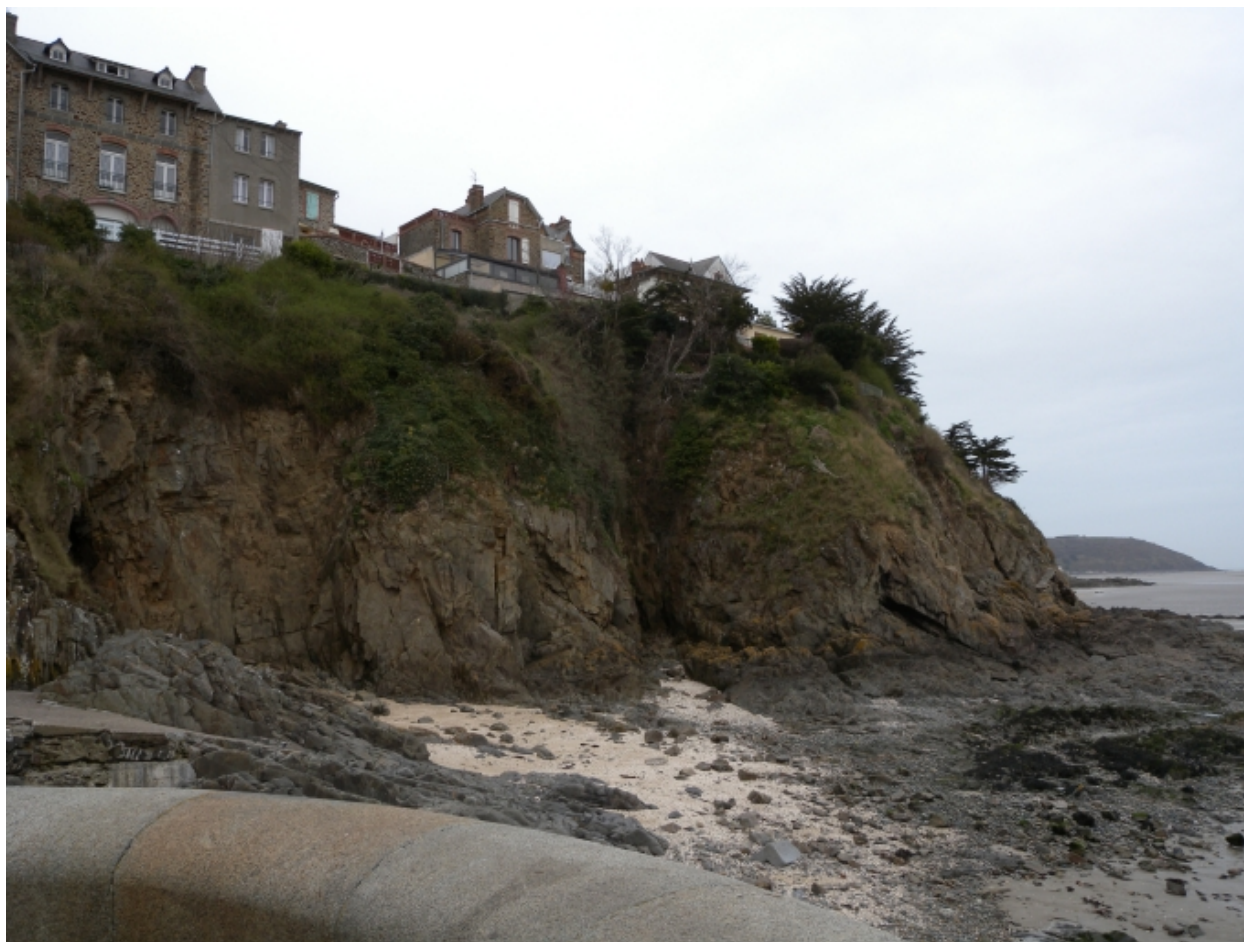
Vue du bâti littoral en front de mer sur la falaise de la Pointe-à-l'Aigle
