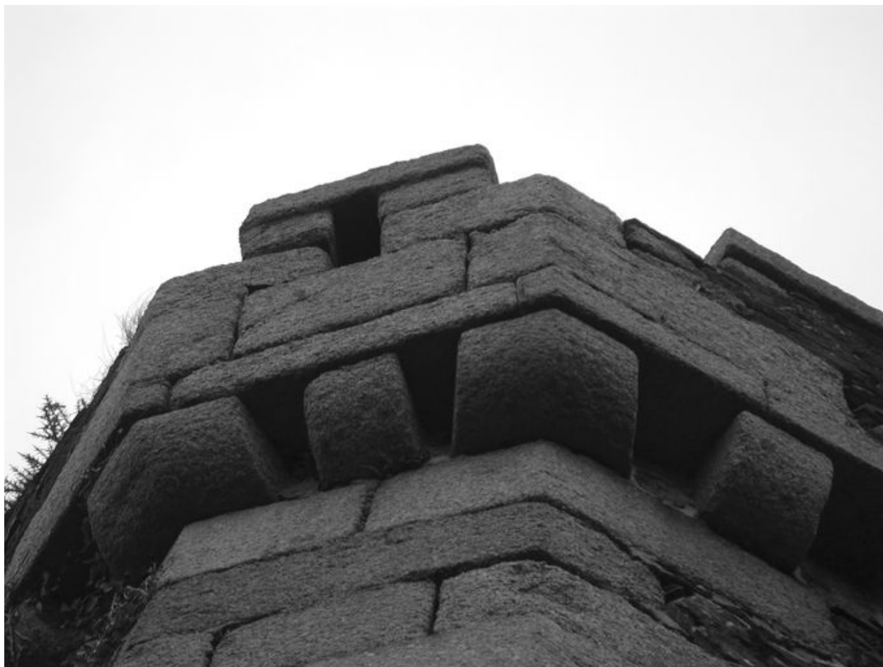
Roscanvel, pointe de Cornouaille : tour-modèle n° 1, créneau de fusillade
