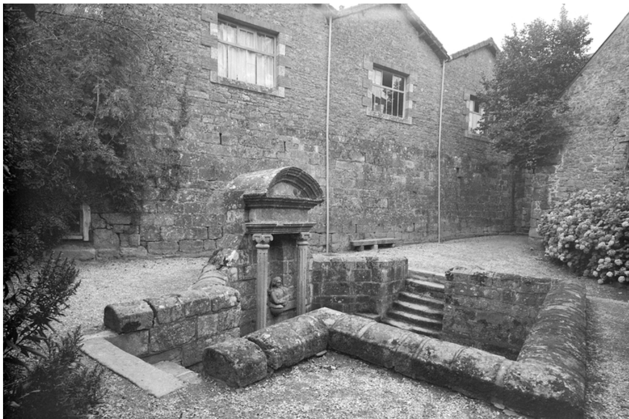
Vue de situation prise du nord ouest
