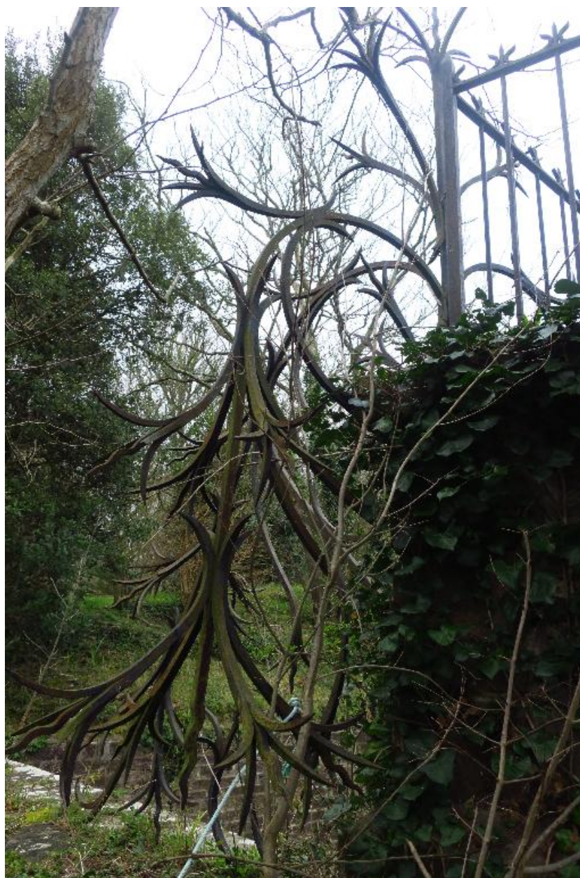
Le Palais, enceinte urbaine, bastion 20, grille défensive.
