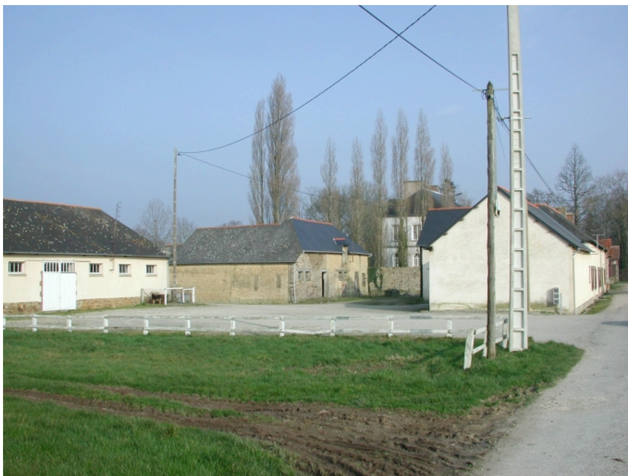
Vue de situation sud-ouest
