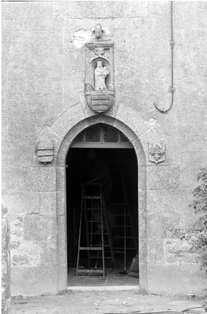
Façade est, détail : porte d'entrée
