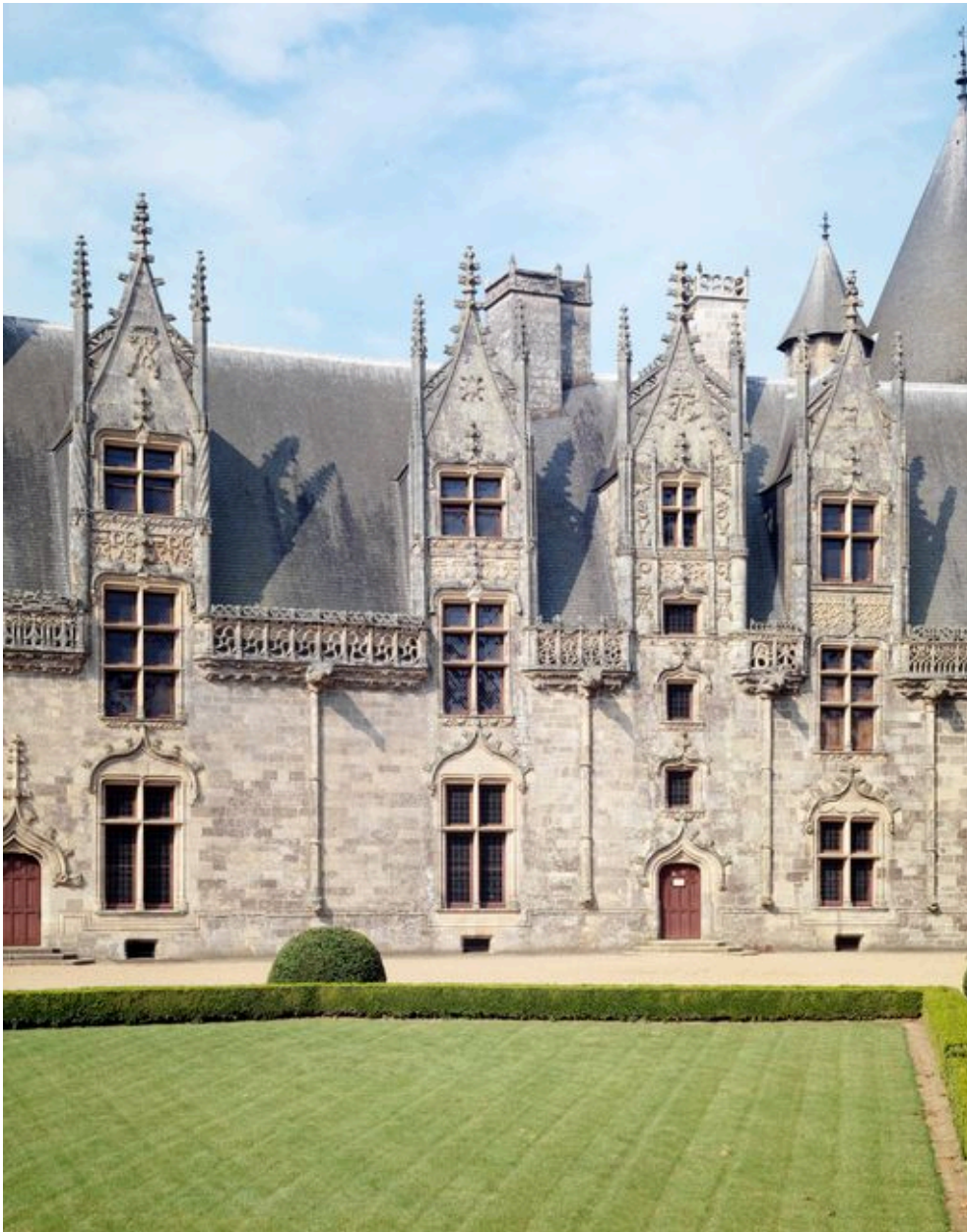
Logis, élévation sur cour : entrée secondaire et travée de la cage d'escalier secondaire
