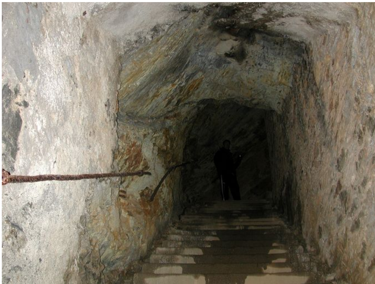
Vue de l'escalier creusé dans le roc (état en 2007)
