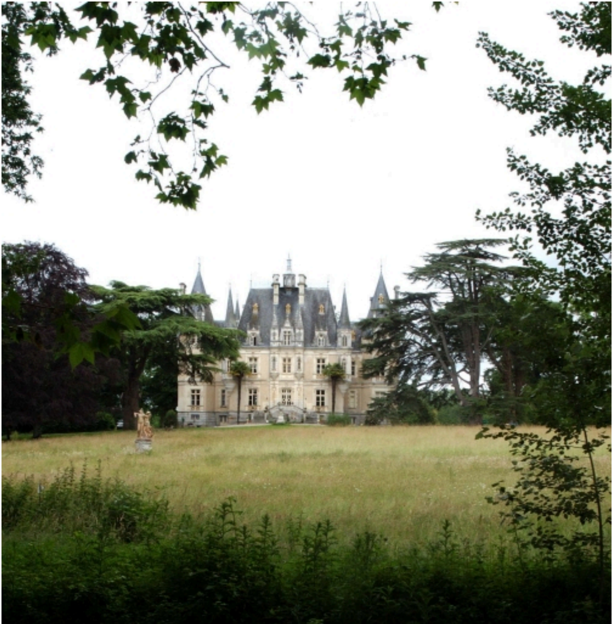
Château, vue générale de la façade antérieure
