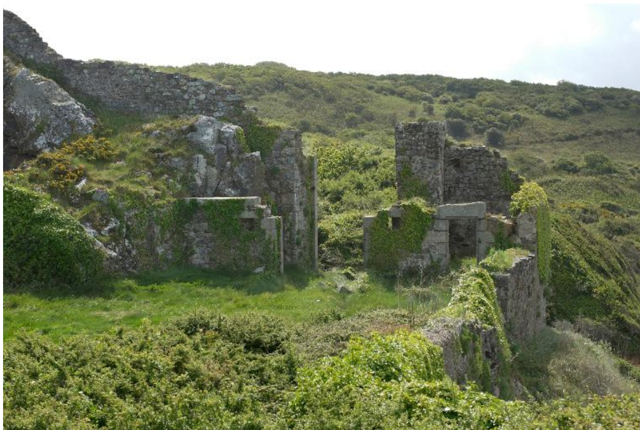
Vue du terre-plein de la batterie basse : porte d'entrée du fort avec tambour et corps de garde (état en 2009)
