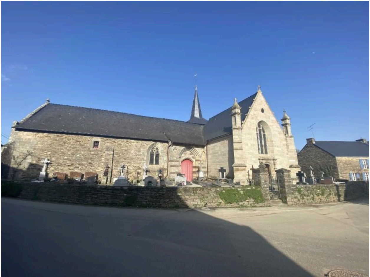
Élévation sud, vue générale
