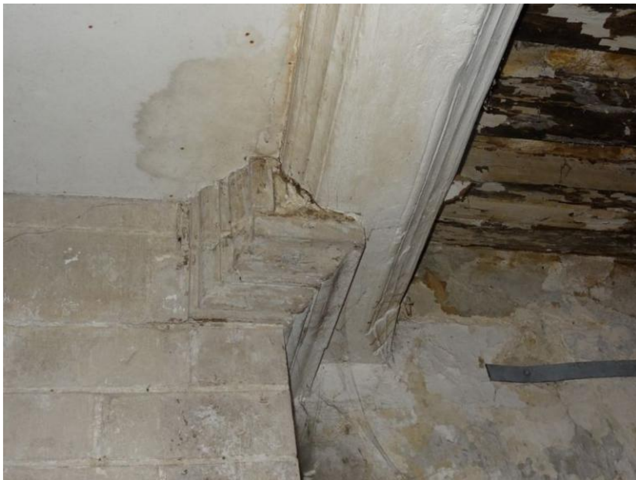
Détail de la corniche haute de la cheminée
