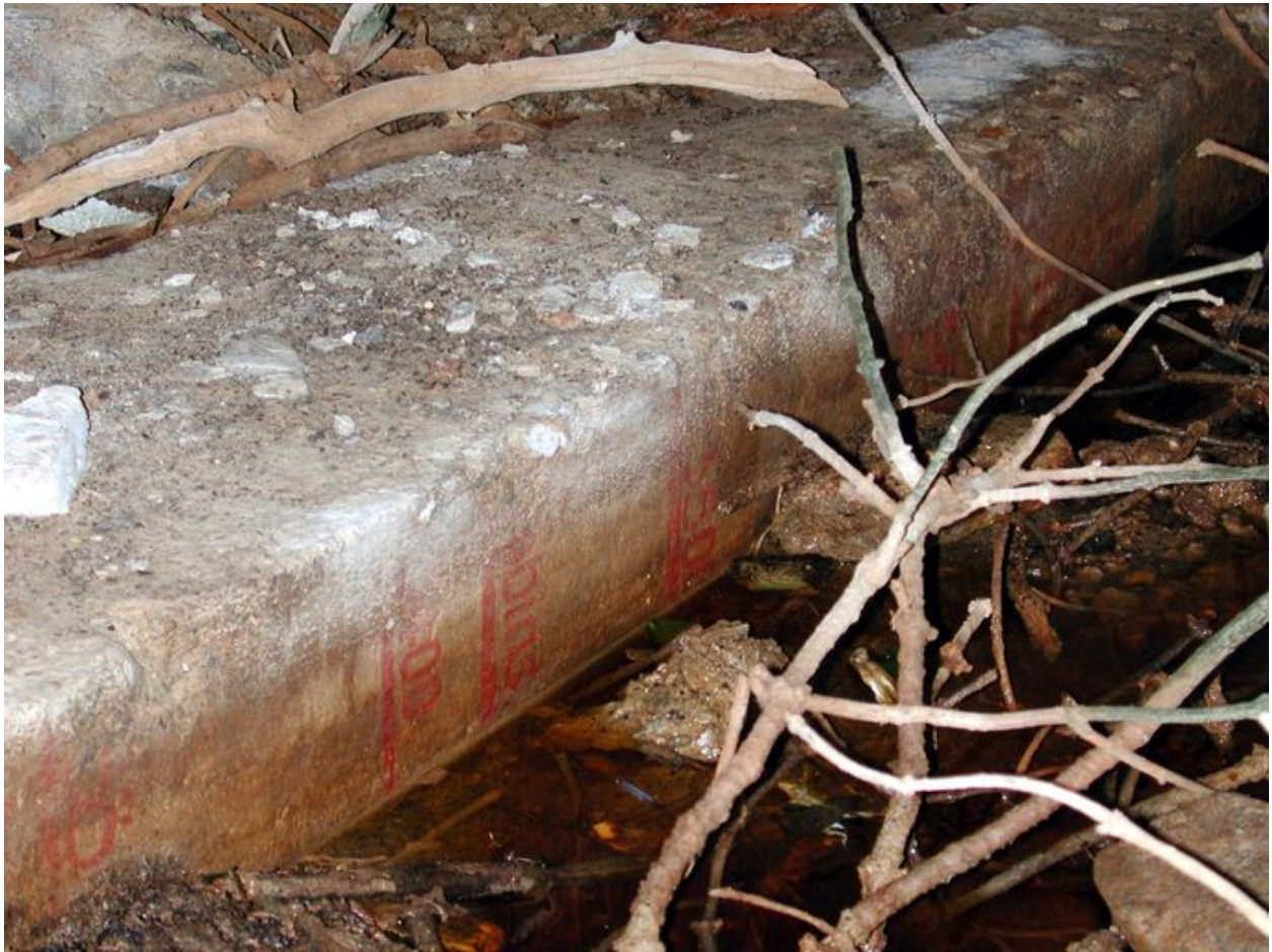
Vue de l'un des marquages présents dans chaque casemate : angle de tir du canon (état en 2002)
