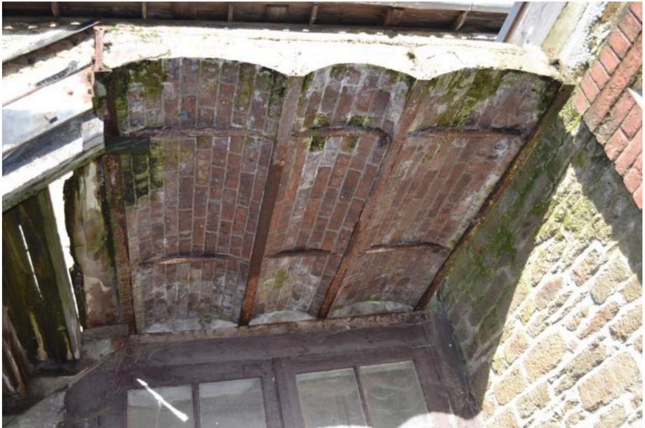
Peignerie. Revers du palier de l'escalier extérieur : entrevous en berceau en brique
