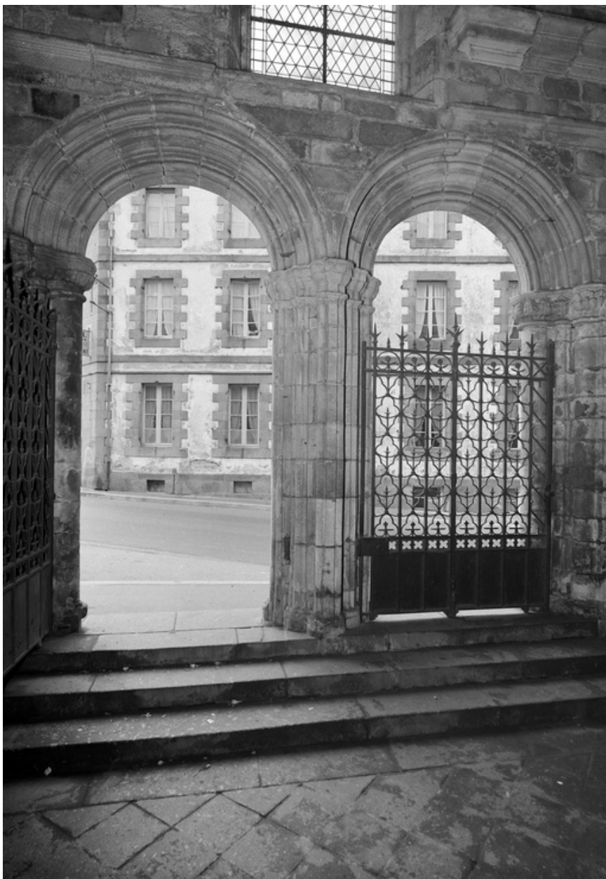
Façade sud, porche, 1er niveau : ouvertures vues de l'intérieur
