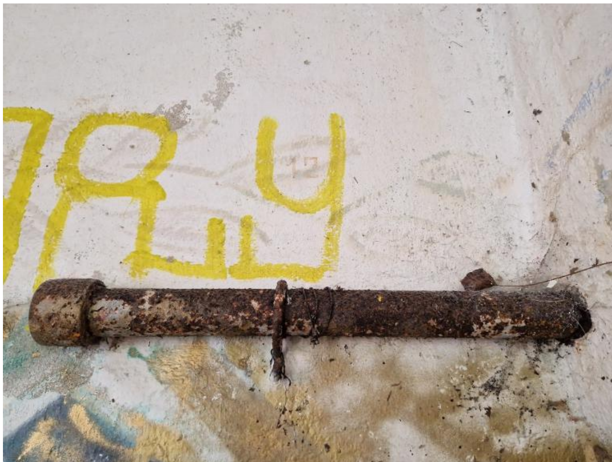
Vue intérieure de l'usine électrique du poste photo-électrique : support métallique pour crochets de hamac et sa numérotation (état en 2024)
