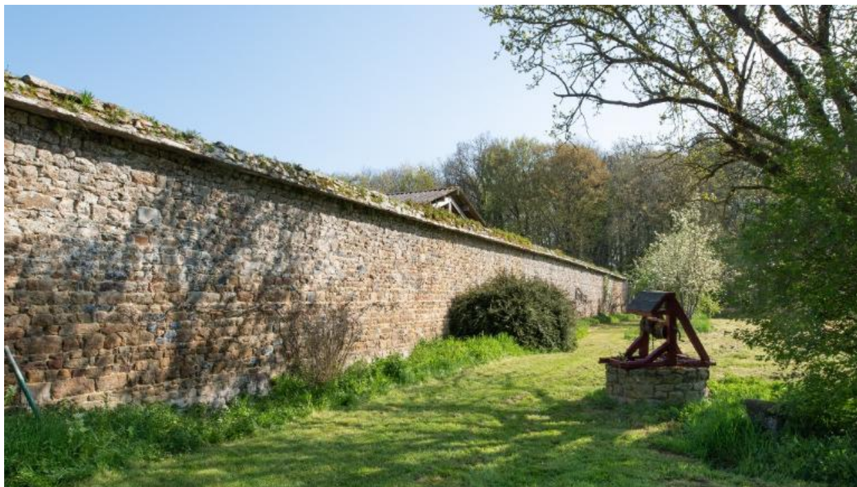
Mur de clôture
