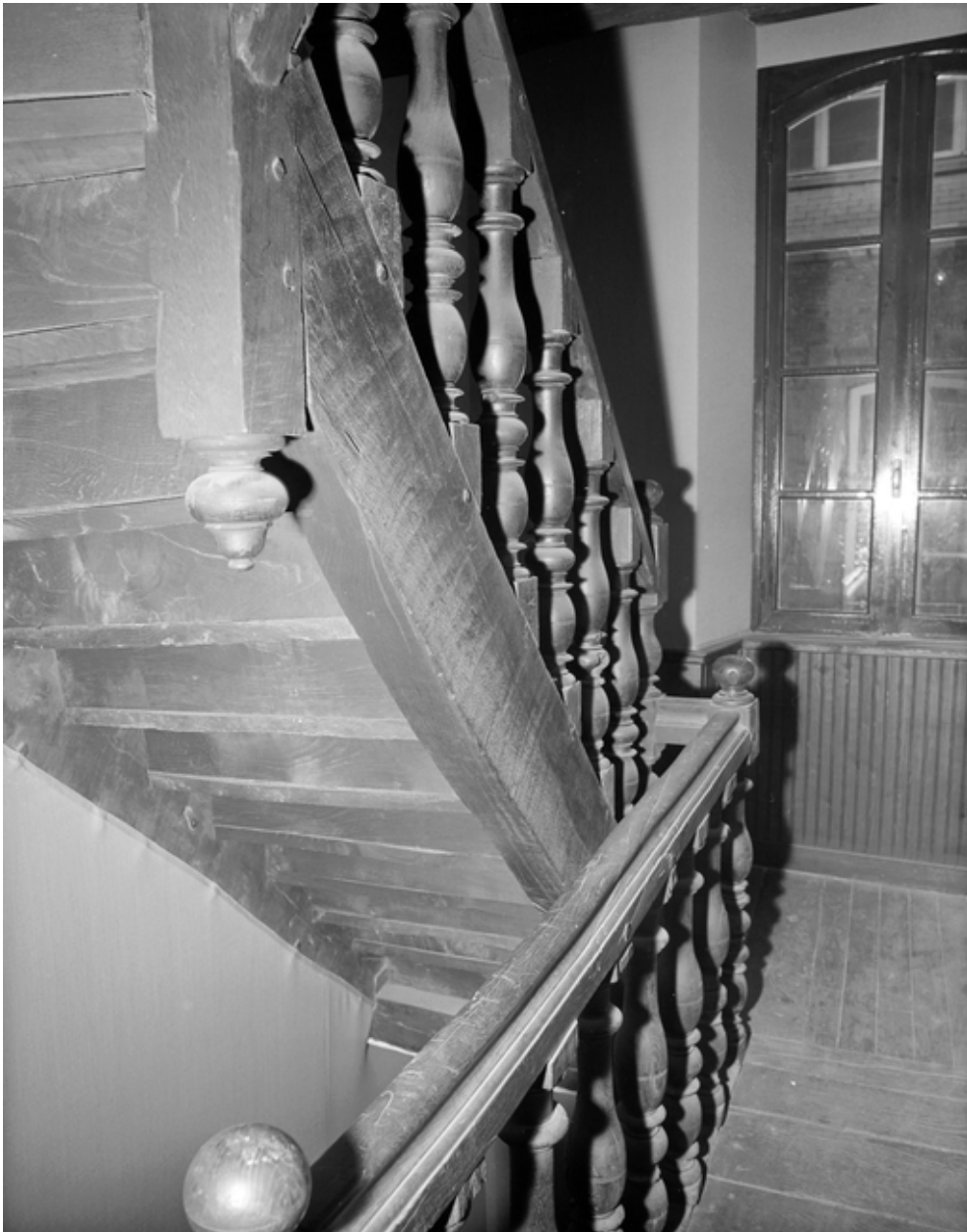
11 rue Nationale, escalier, volées du deuxième étage.
