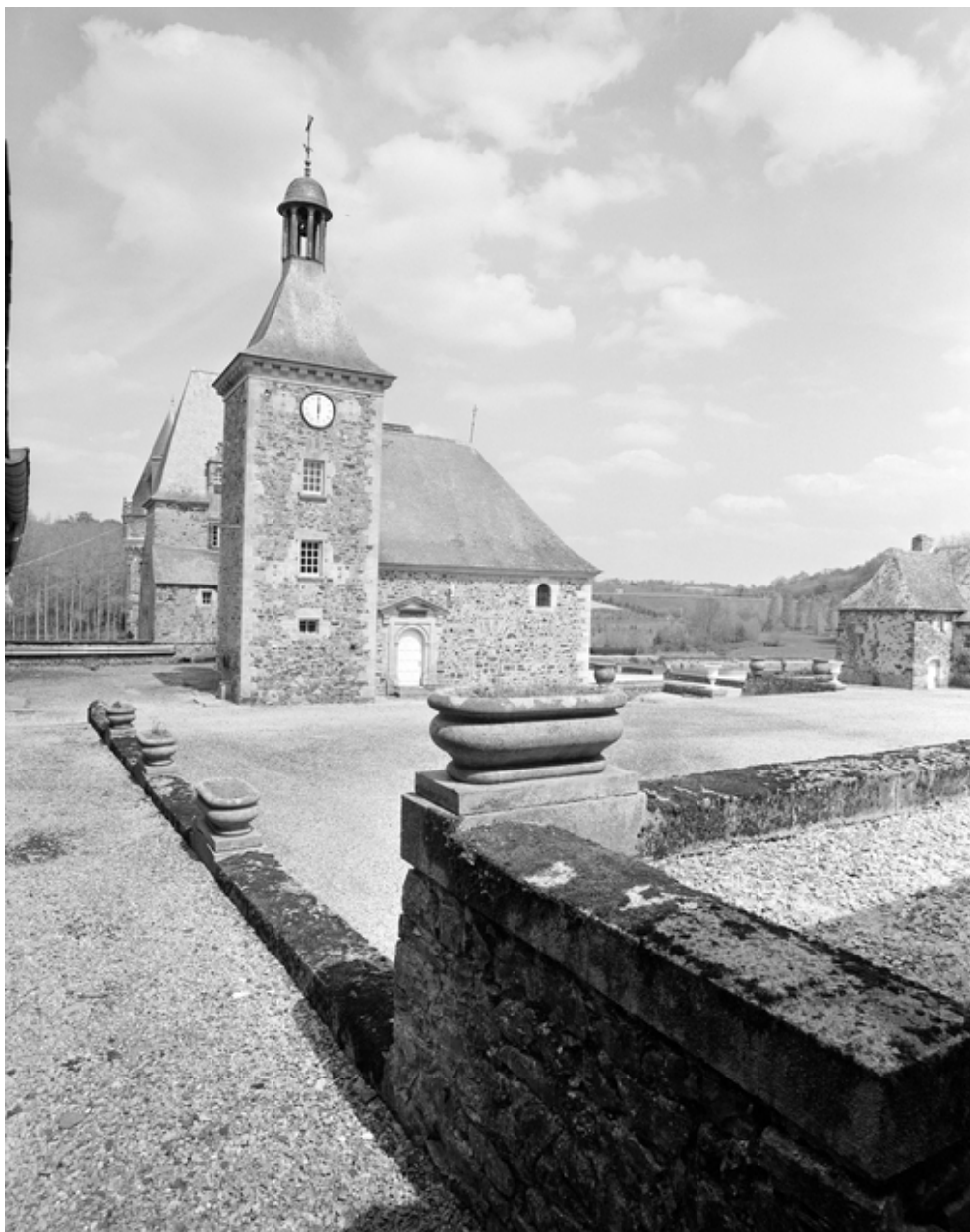
Clocher et chapelle : vue d'ensemble sud-ouest.
