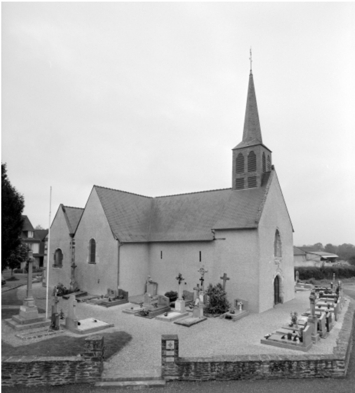
Elévation Nord-Ouest : vue générale
