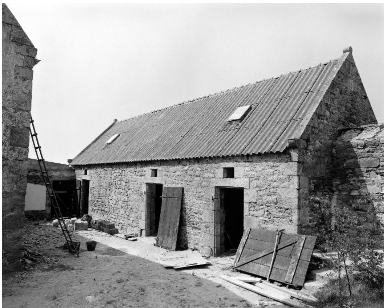
Praterou, Ferme : étable au nord, vue générale sud
