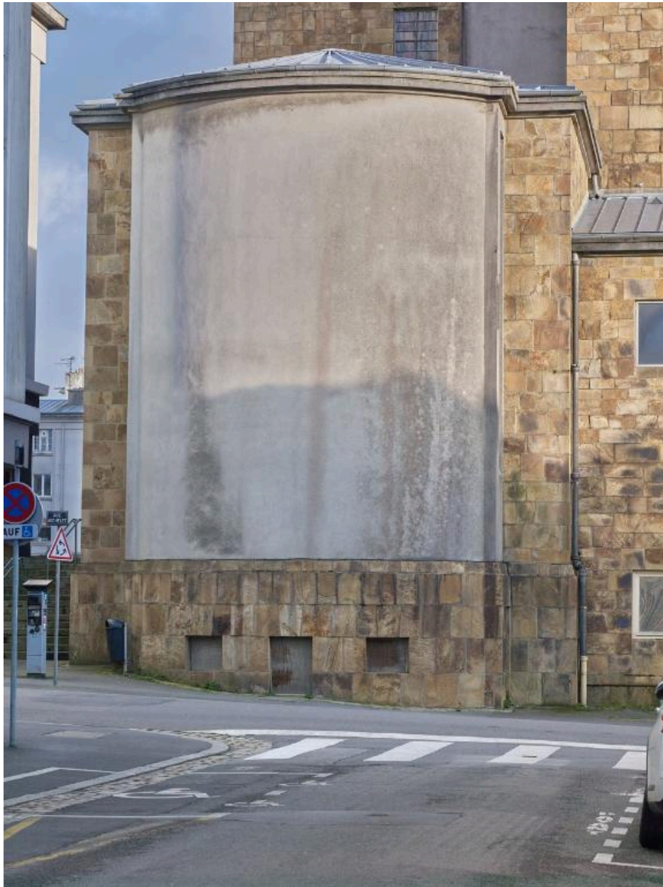
Église Saint-Louis, élévation sud, vue rapprochée
