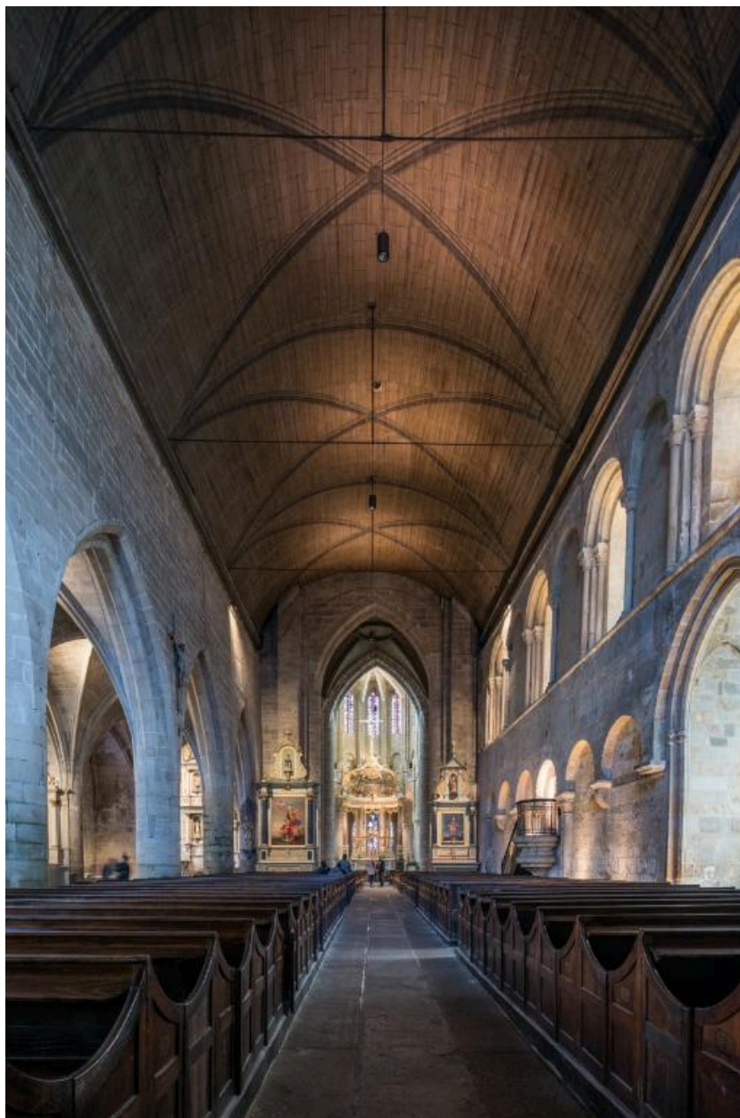
Vue générale de la nef vers le choeur
