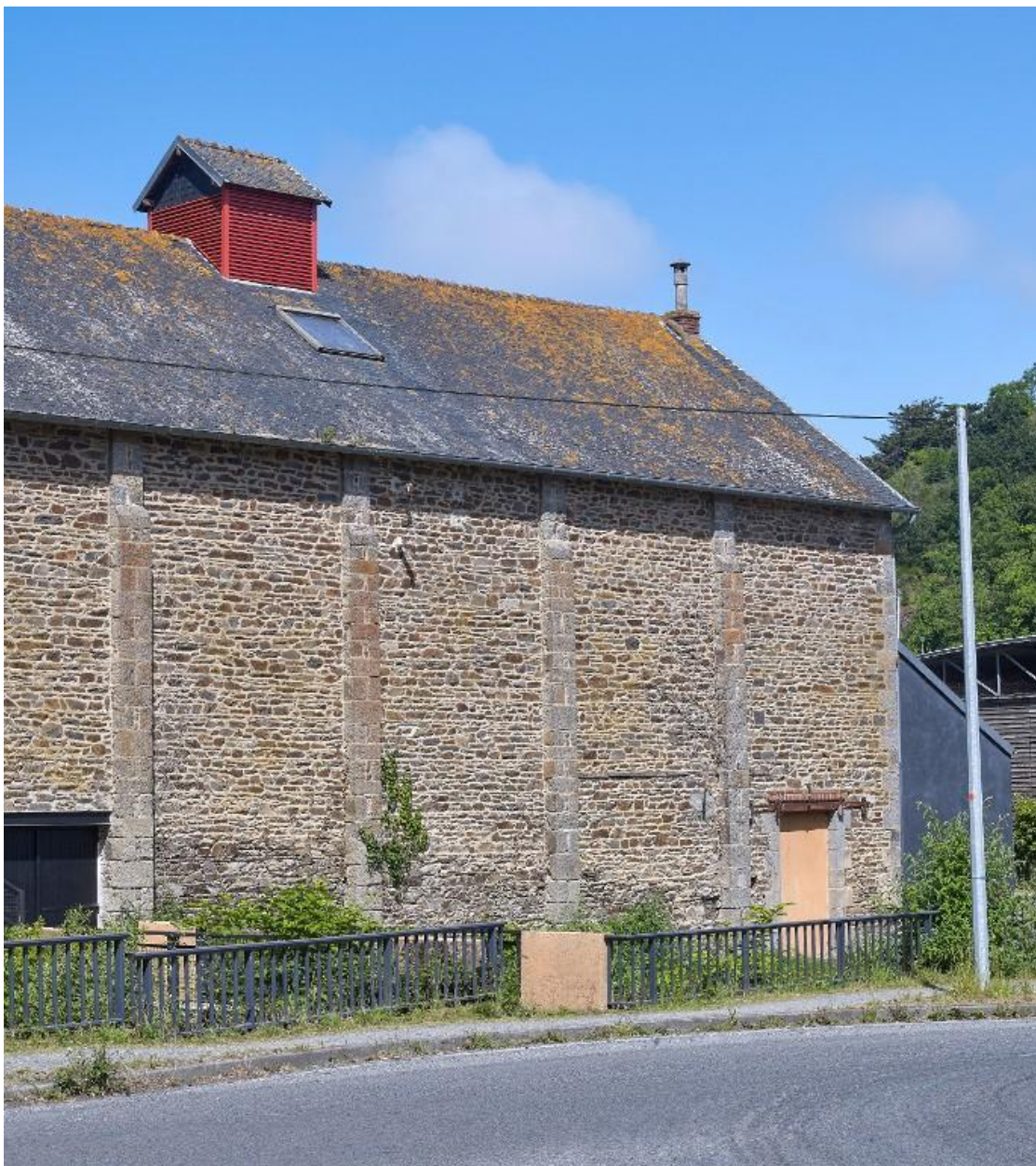
Elévation est de l'ancien entrepôt, vue rapprochée
