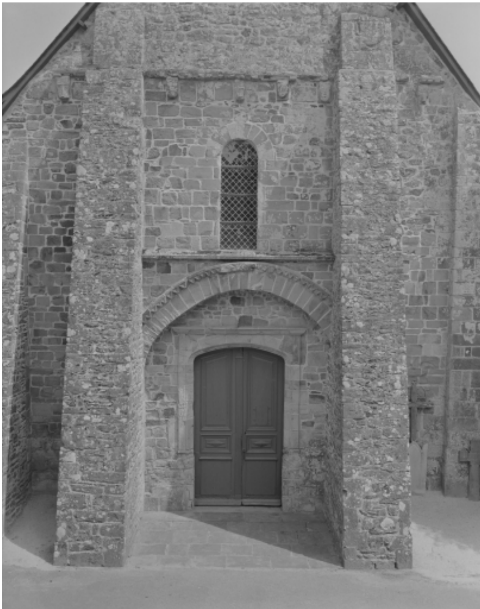
Elévation ouest, porte : vue générale
