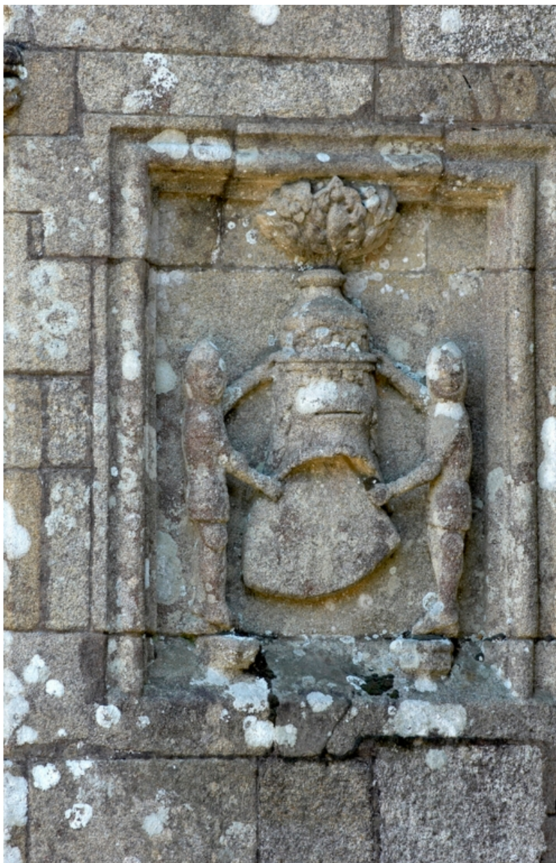
Chapelle sud-ouest, armoiries à droite de la fenêtre
