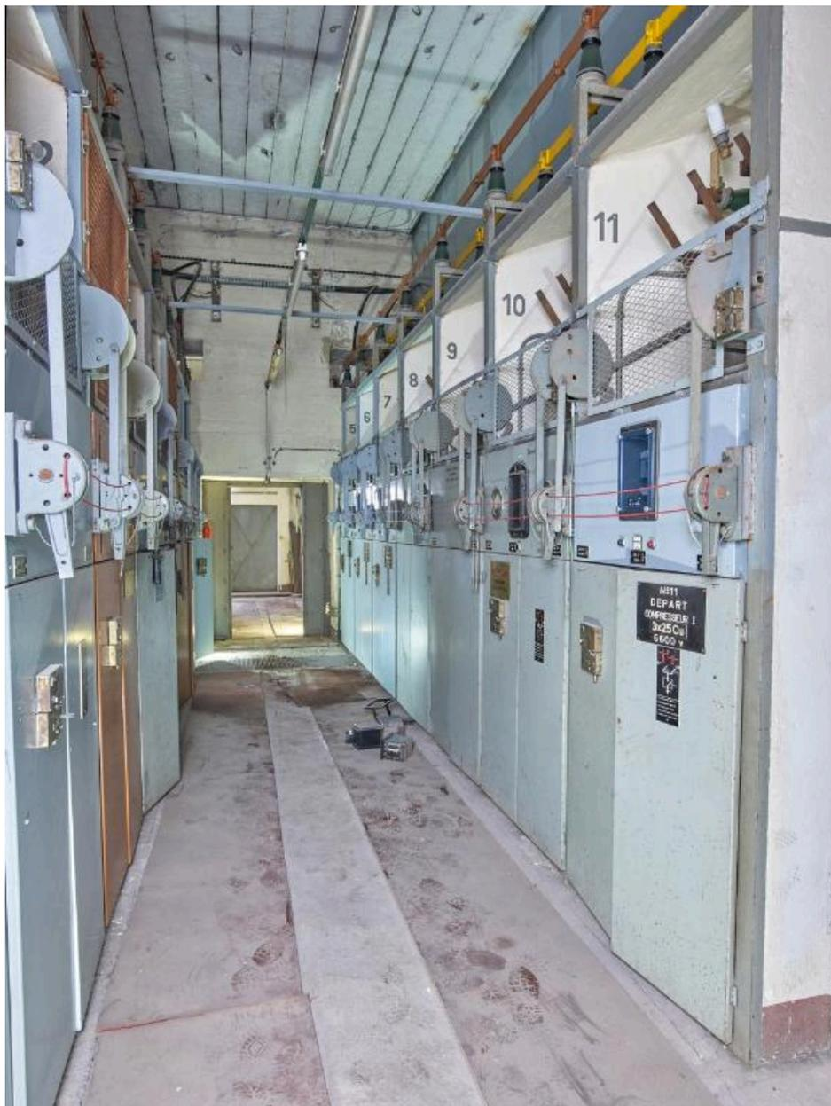
Vue des cellules hautes-tensions situées au deuxième étage : parties arrières des cellules n° 5 à 11. Les tapis isolant sont encore disposés au sol
