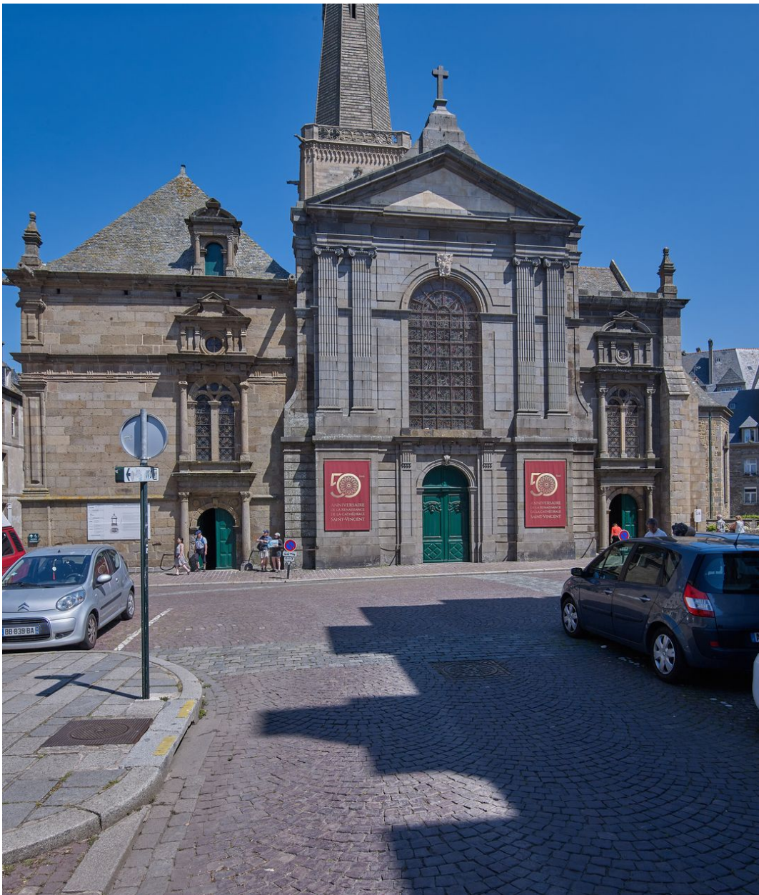
Elévation ouest, vue générale
