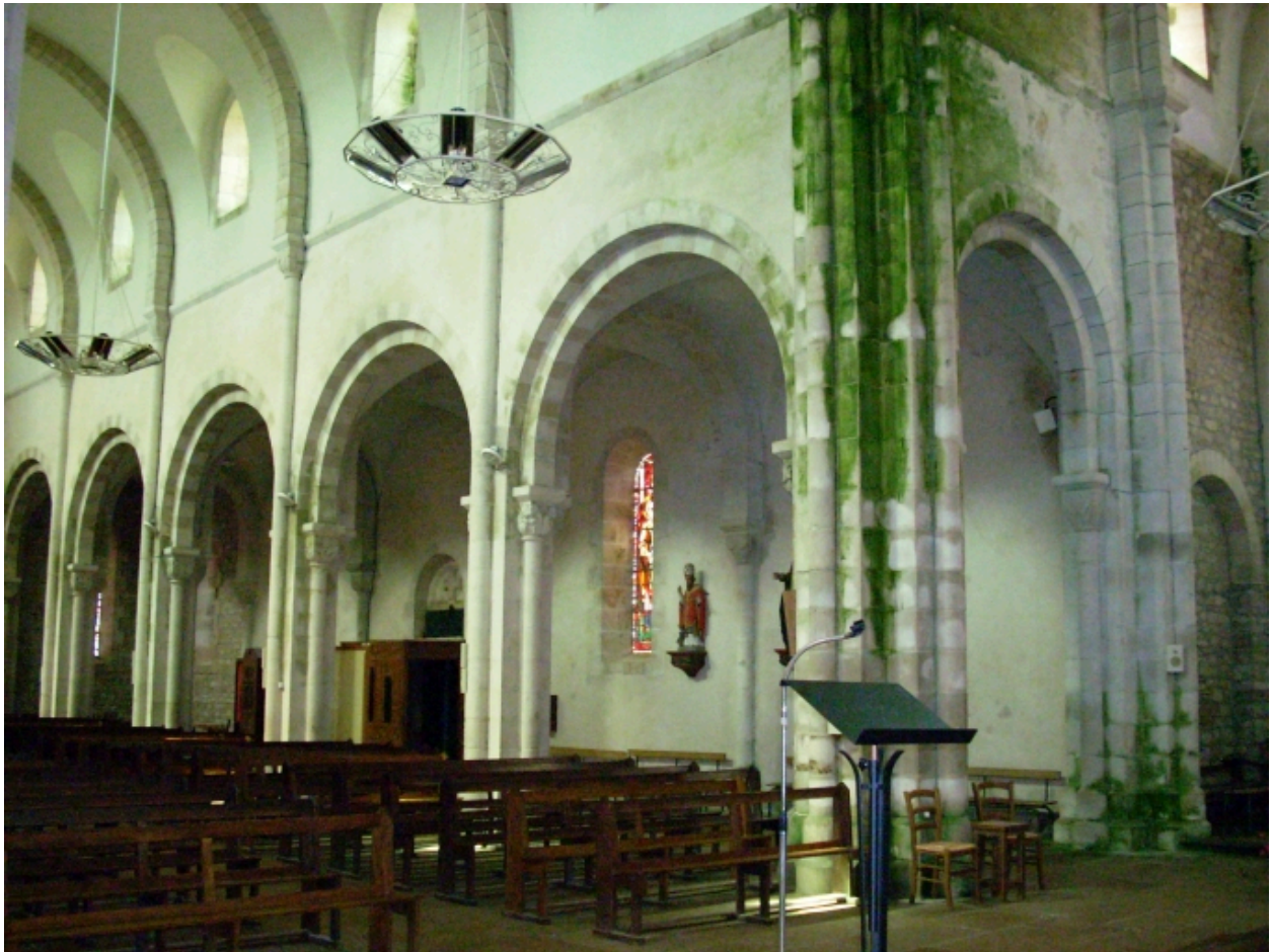
Scaër, église paroissiale Sainte-Candide : détail bas-côté nord depuis le choeur
