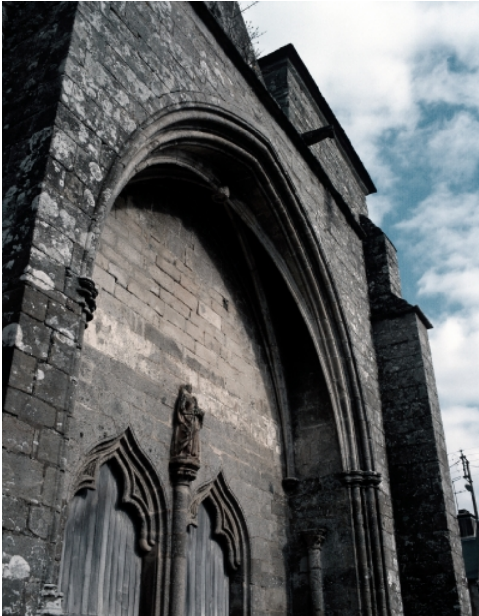
Elévation ouest, voûte du portail
