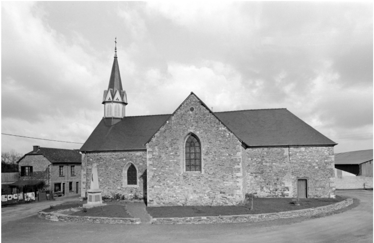
Elévation Sud : vue générale
