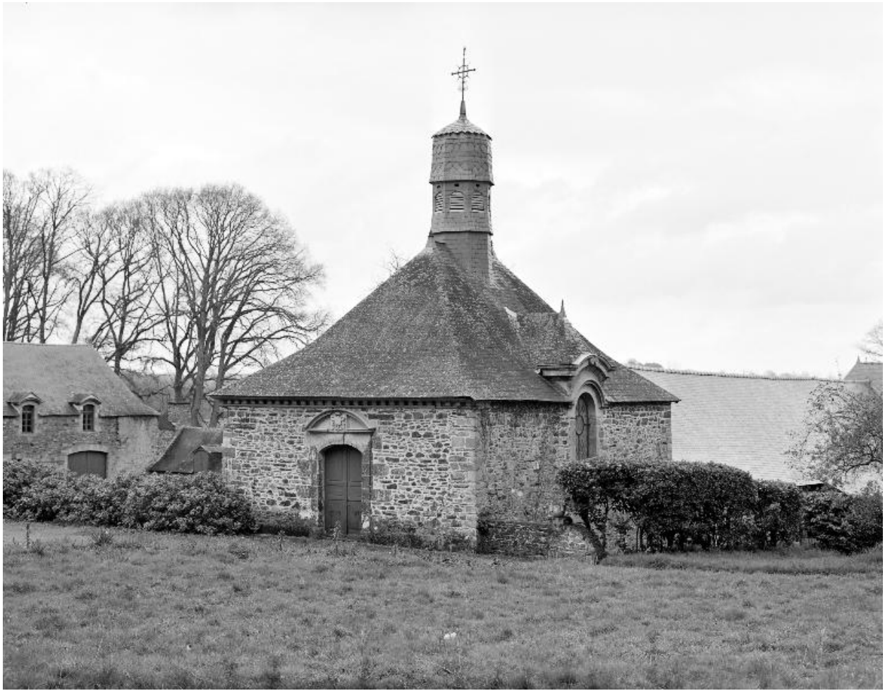
Château : la chapelle vue du sud-ouest (état en 1983)
