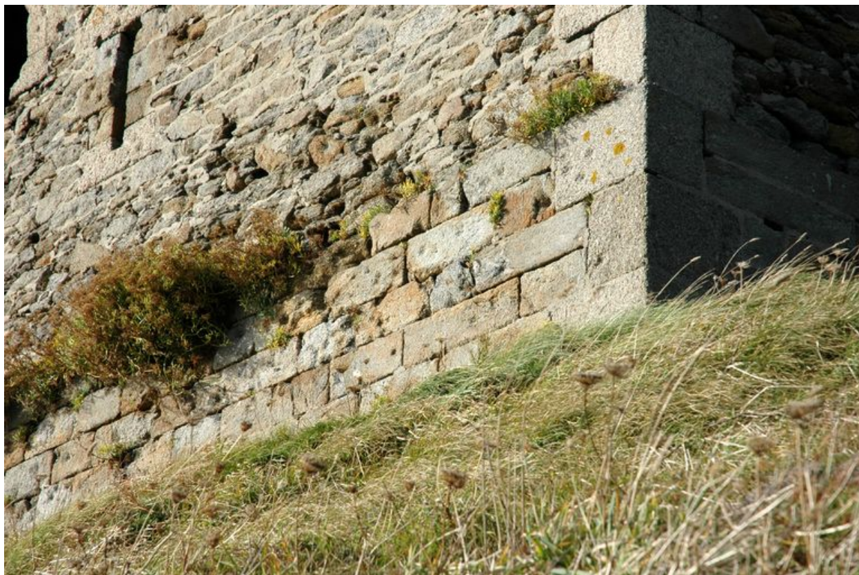
Elévation Sud : détail des fondations du réduit
