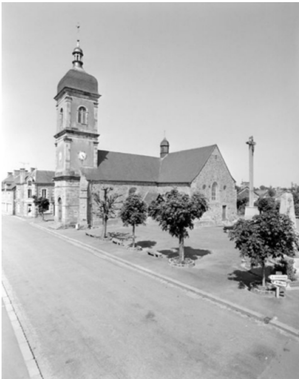
Elévation sud-ouest : vue générale
