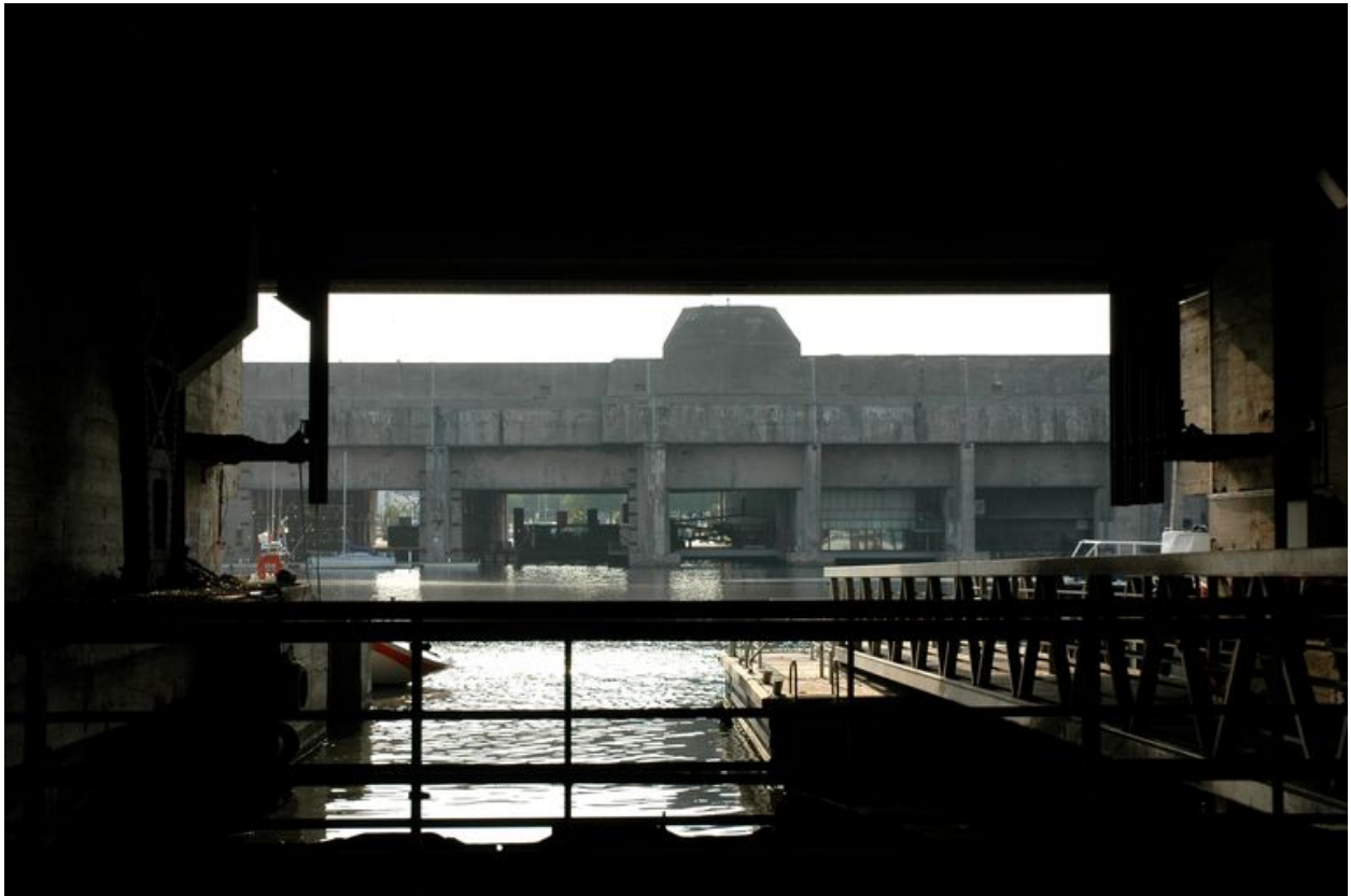
Vue de la base de sous-marins de Saint-Nazaire depuis l'écluse bétonnée
