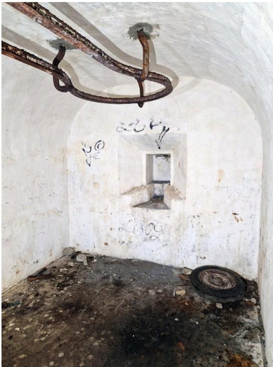
Vue intérieure du magasin à munitions : extrémité est avec créneau à lampe, fixations et rail pour la manutention des obus via un palan
