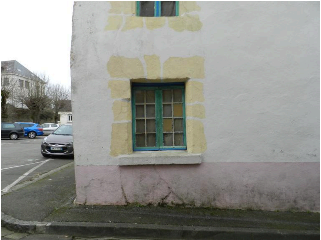
Fenêtres, 4 rue de la paix
