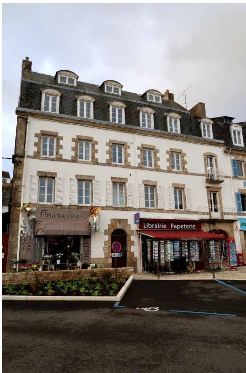
Immeuble au 2, quai Jean Jaurès, élévation antérieure. (2020)
