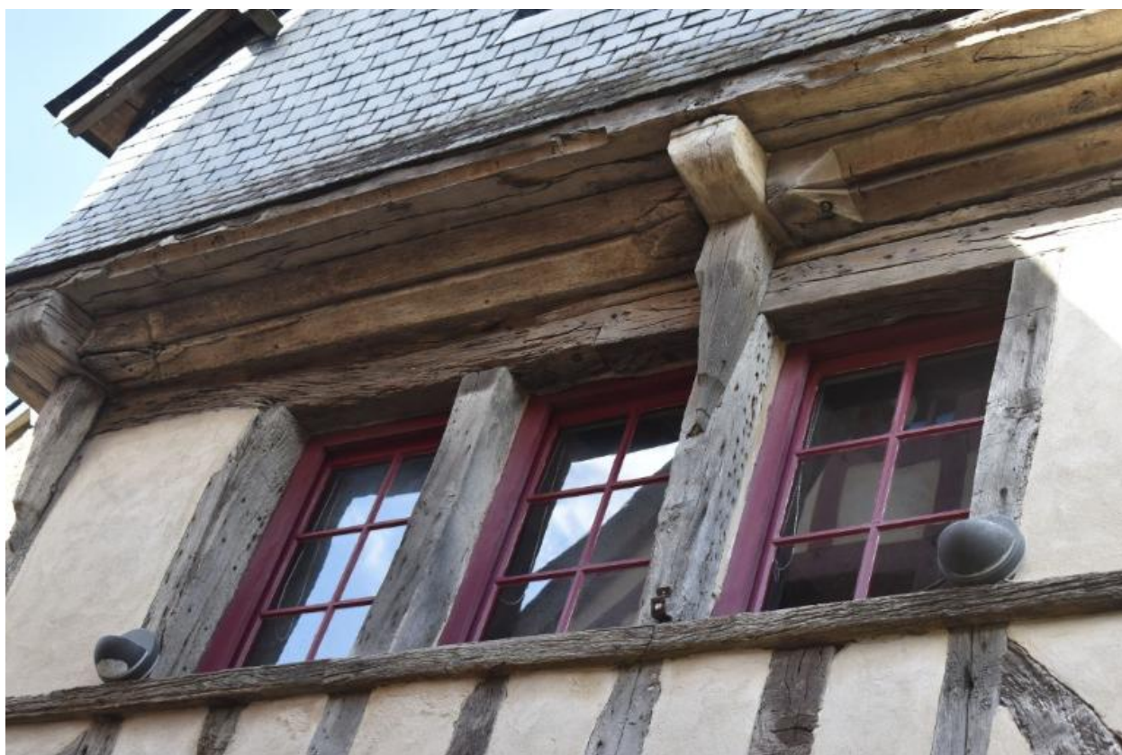
Détail de la galerie des fenêtres surmontées des sablières d'encorbellement et des solives
