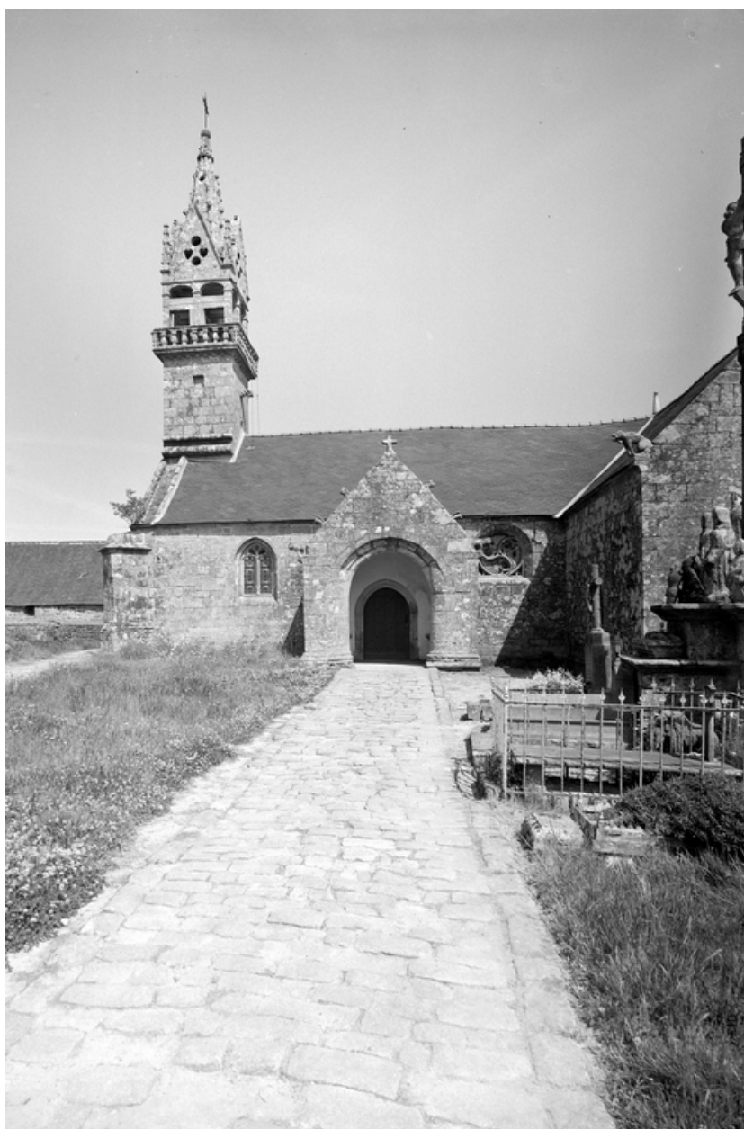
Façade sud : vue générale du clocher et du porche
