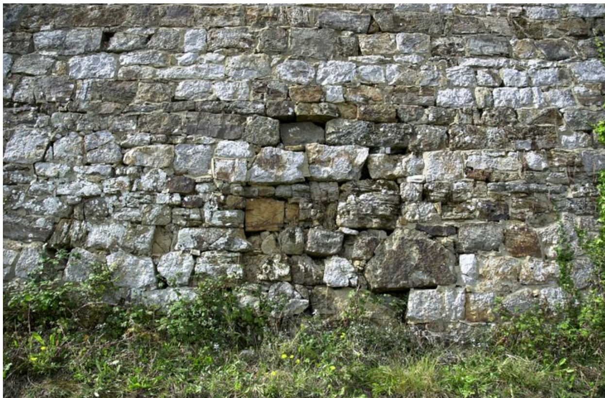
Vue du fort de Lanvéoc : détail du parement
