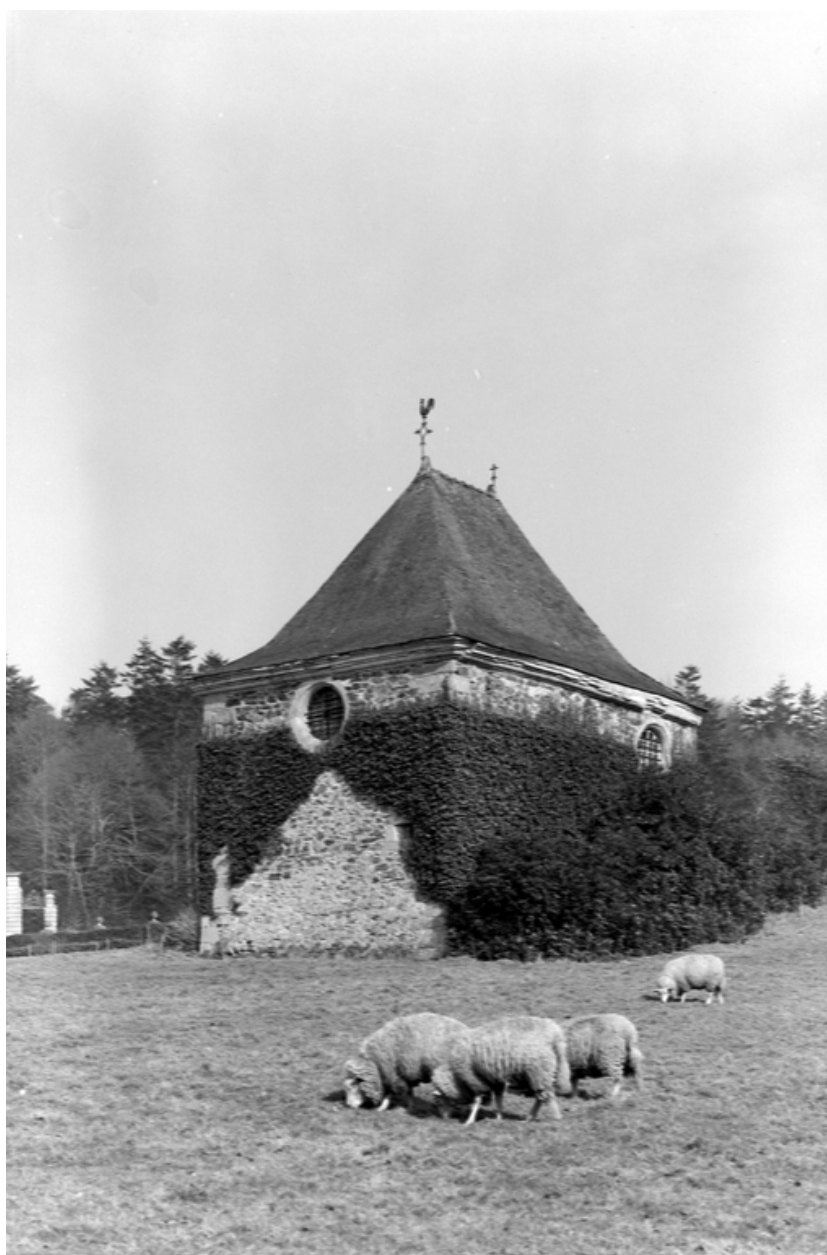
Chapelle : vue générale sud ouest
