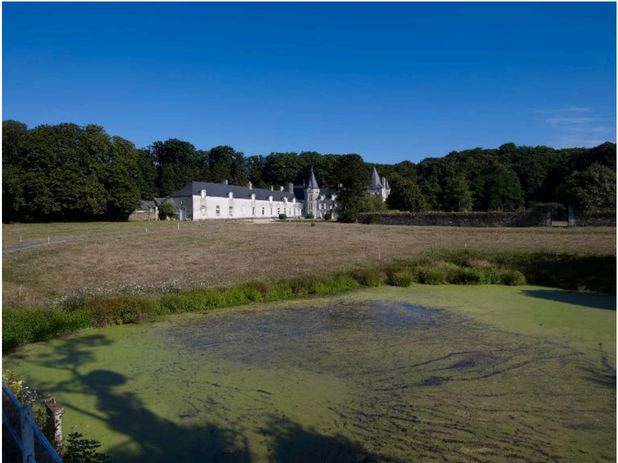
Logis, vue de situation sud-est
