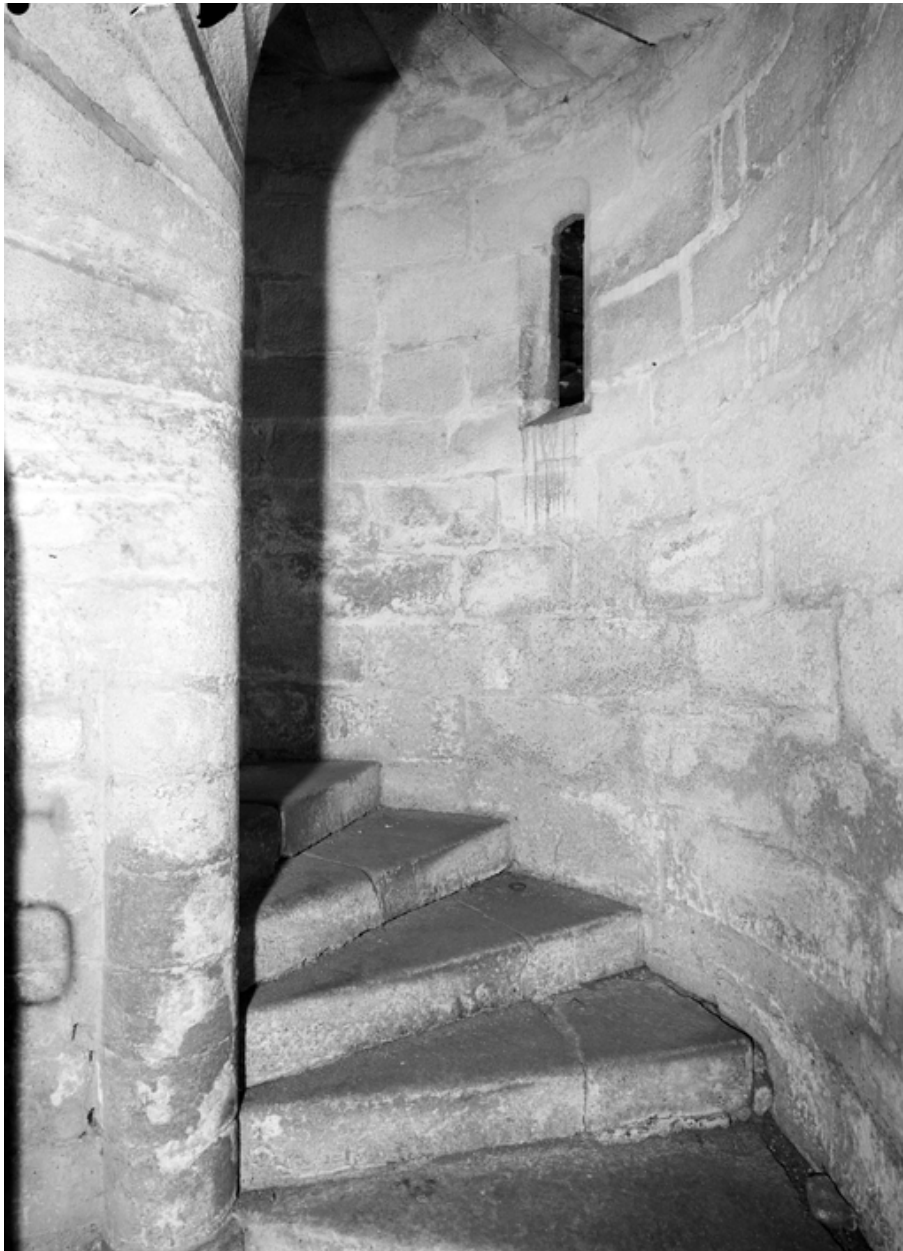
Intérieur de la tourelle d'escalier.
