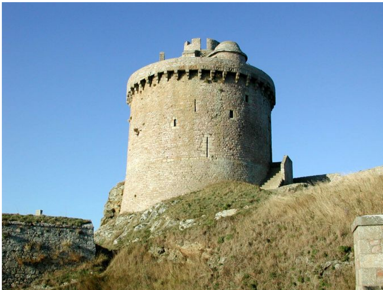
Vue du Fort La Latte
