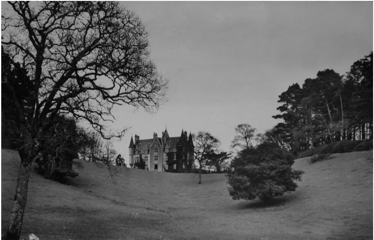
Vue de situation dans les années 1960
