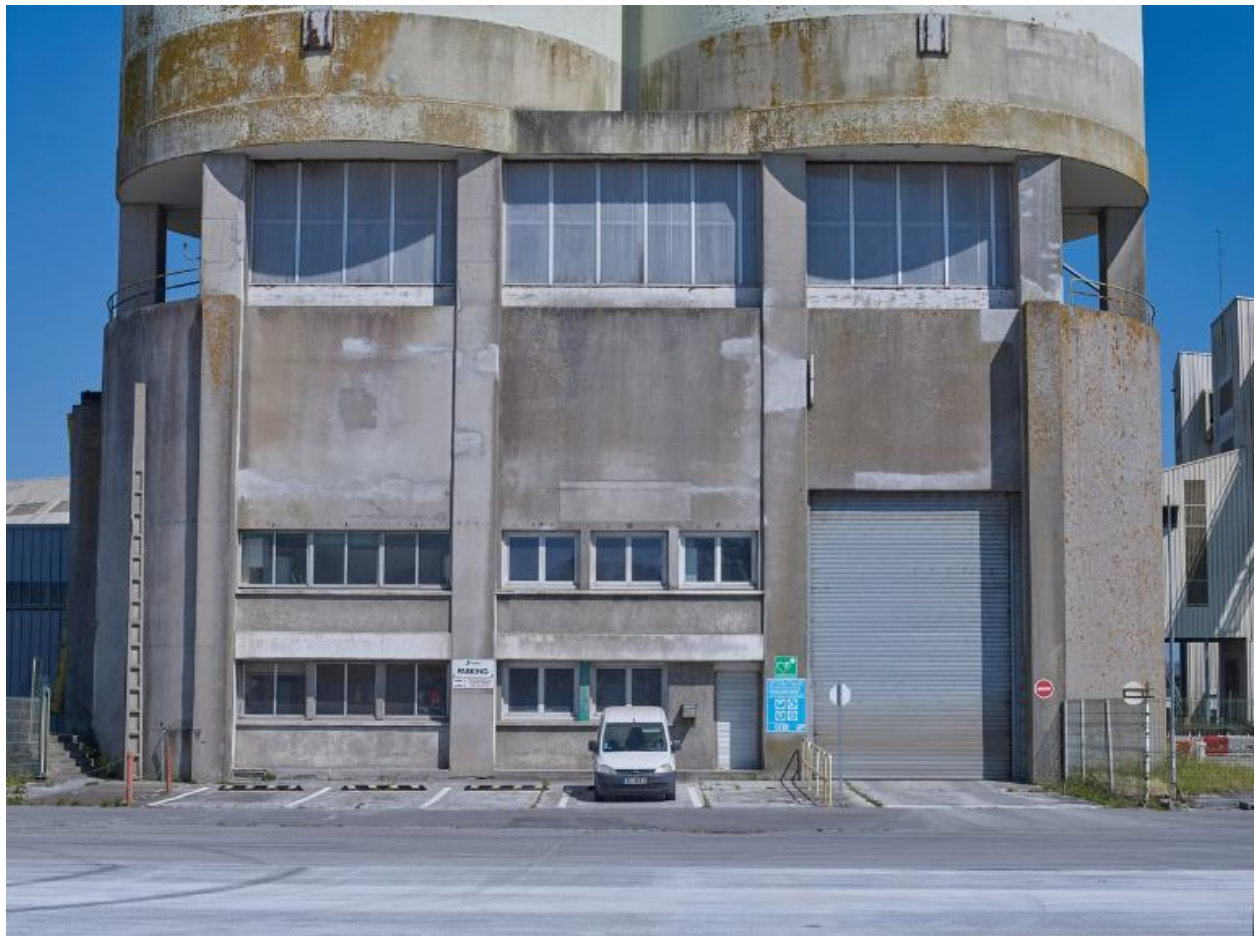
Partie inférieure du silo : bureaux et accès camions
