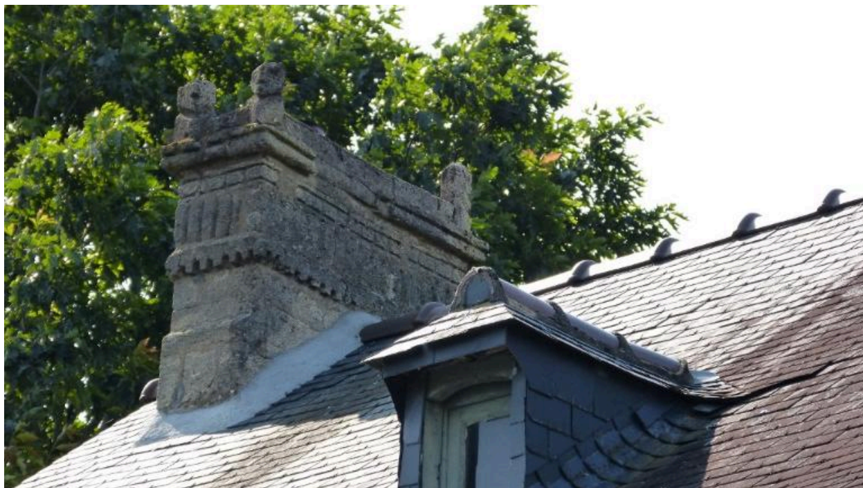
Détails de la souche de cheminée
