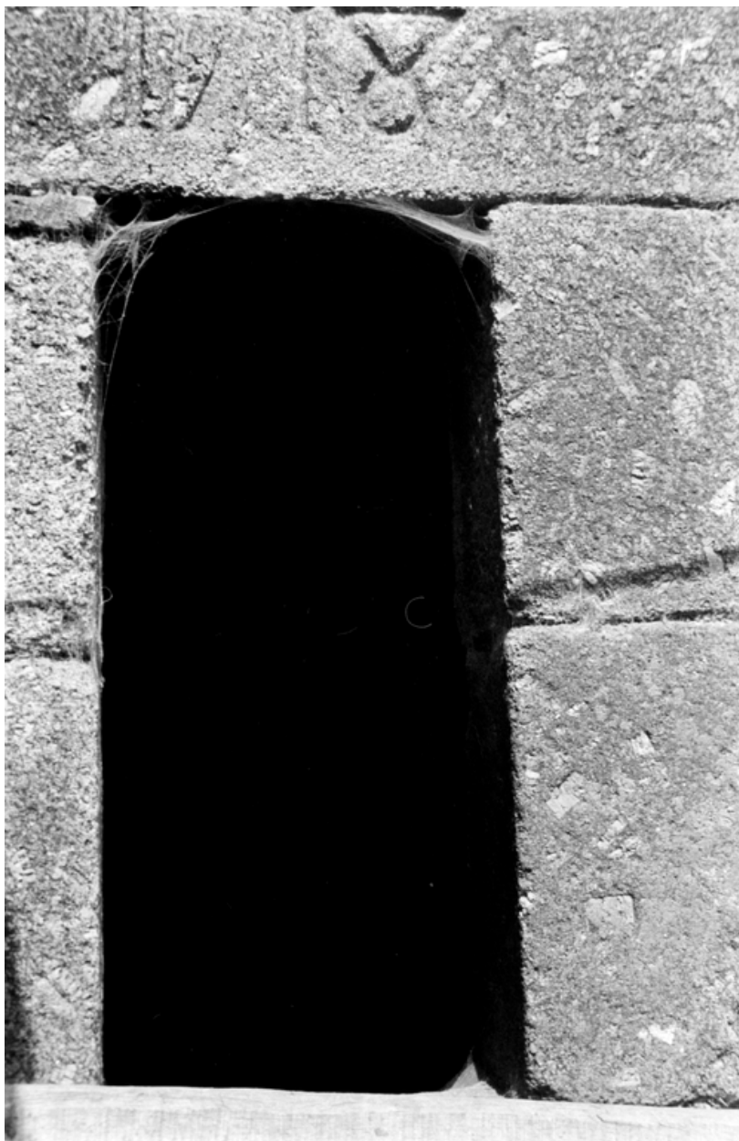
Etable à l'ouest du bâtiment principal, façade sud : détail de la fenêtre, 1er niveau à l'est
