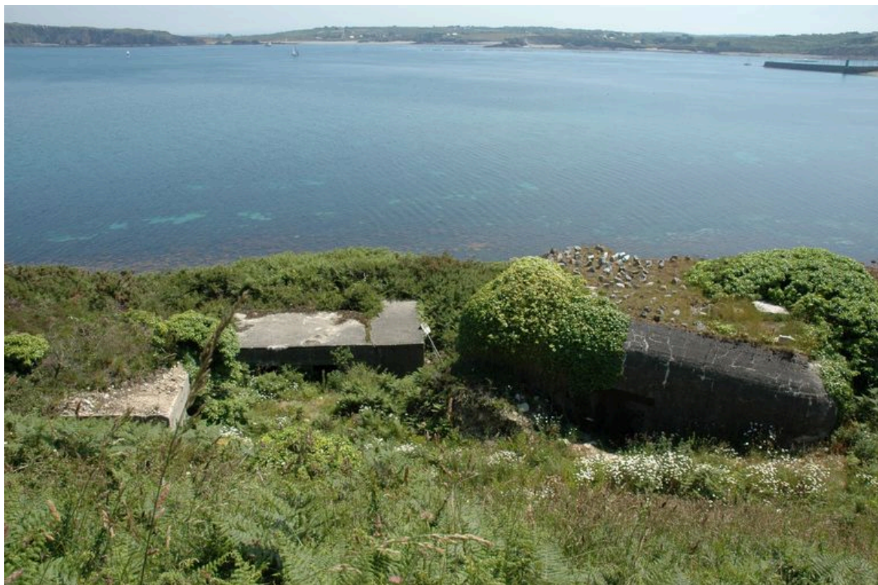
Vue du bunker - casemate de type 671 sud et deux abris en béton armé (état en 2005). Le site est envahi par la végétation
